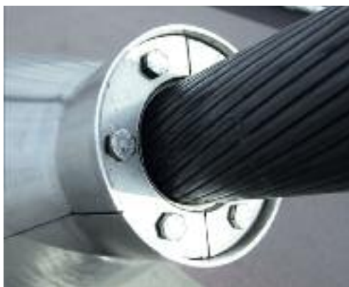
Figure 26 : Il n'y a pas de corrosion galvanique entre différents types d'inox, même s'ils n'ont pas la même résistance à la corrosion
