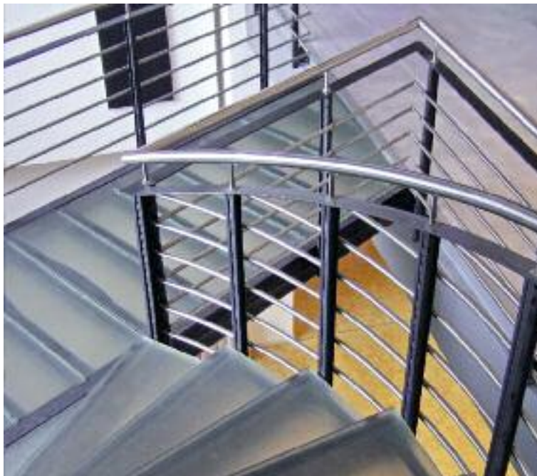
Figure 5 : L'absence typique d'électrolytes dans un environnement intérieur normalement chauffé et aéré diminue le risque de corrosion galvanique lors de l'association d'inox avec d'autres matériaux métalliques comme l'acier au carbone peint.
